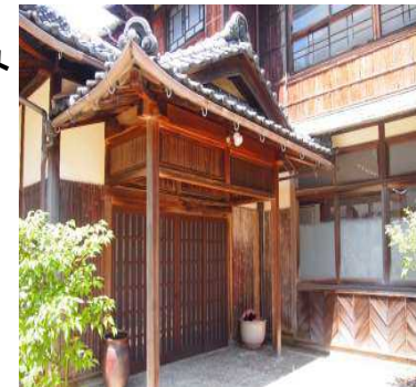
明治37年開業の松栄館別館
