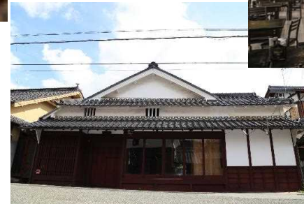
現況建物外観
