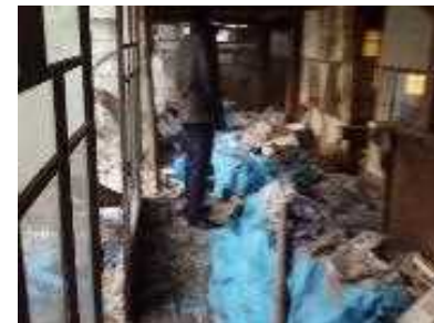
改装前の施設内写真
